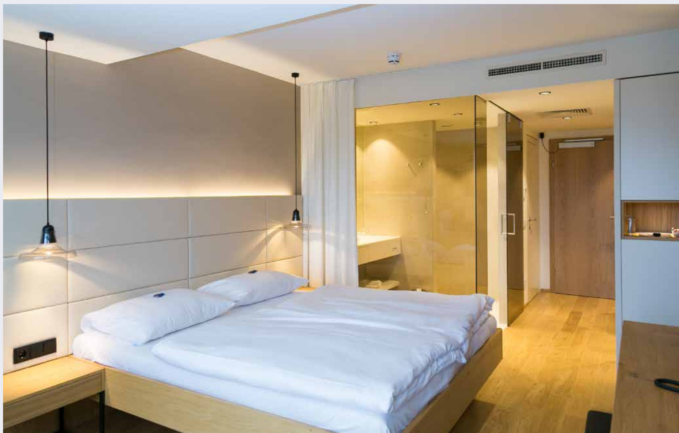
Hotel KOWALD Loipersdorf, tvrtka PAMMER GesmbH Kälte-Klima-Technik
