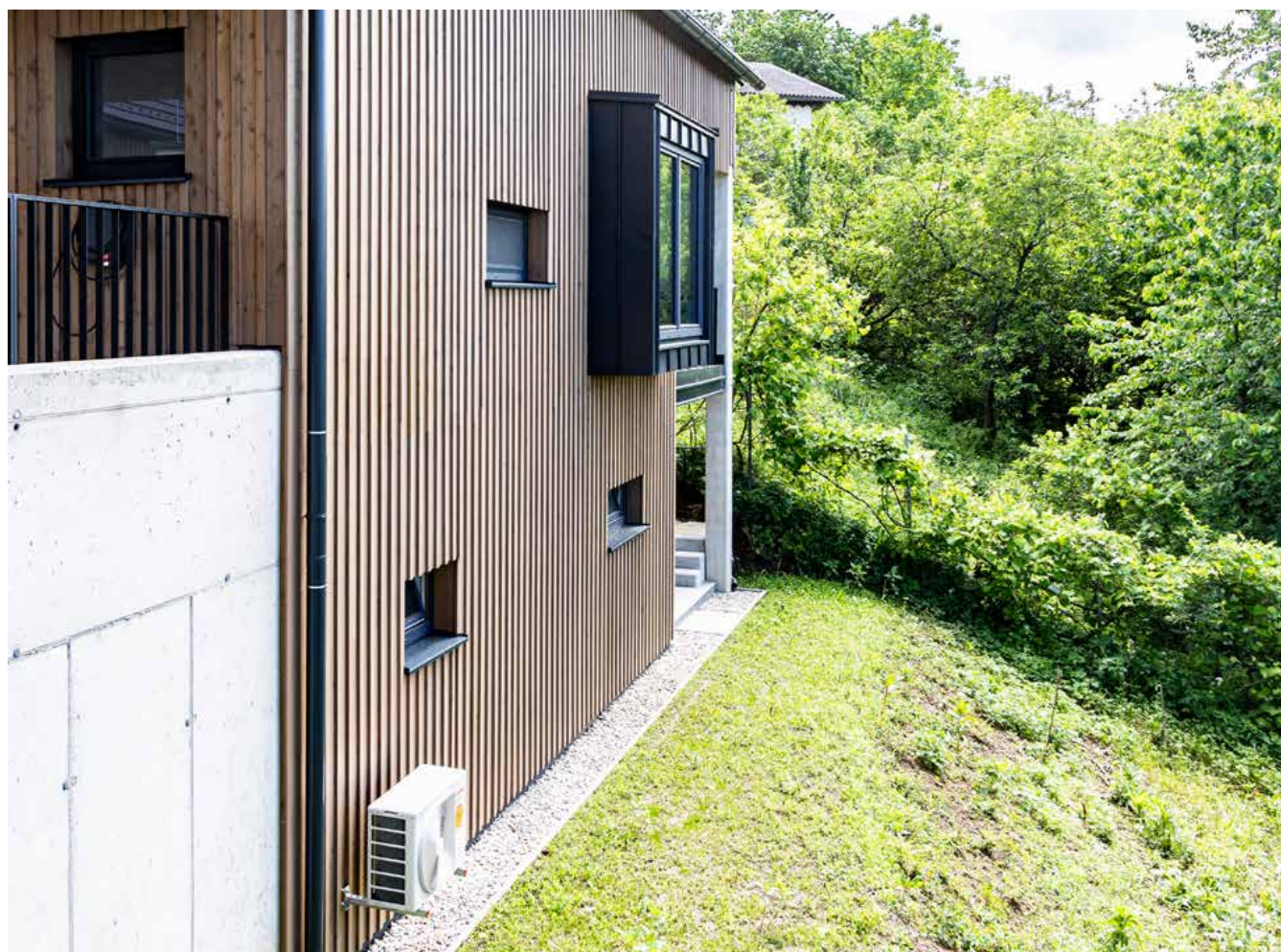
Kuće za odmor Weinzeit Chalets Gamlitz, tvrtka Cool Company Kälte - Klima - Gastro
