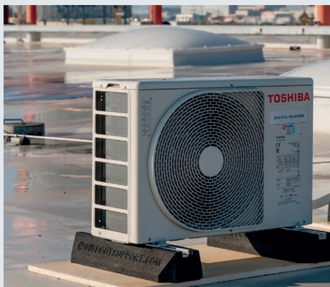
PADO šoping galerije Parndorf, CAVERION Österreich GmbH Klimaanlage und Wärmepumpen
